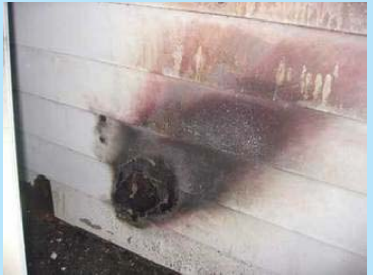
รอยไหม้บนผนังด้านนอกของอาคารหลังหนึ่งซึ่งเกิดจากการอาร์กของสายไฟฟ้าแรงสูงขนาดกำลังคืน 4,000 โวลต์ ที่ขาดตกลงมาใส่และสัมผัสแค่เสี้ยววินาที
