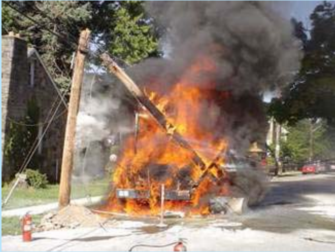
เสาไฟฟ้าโค่น หม้อแปลงตกลงพื้นแตกกระจาย สายไฟแรงสูงขาดตกลง ฆาพาทหลังครรถซ่อมบำรุงไฟฟ้า ทำให้เกิดการอาร์กอย่างรุนแรงจนไฟลุกท่วม
