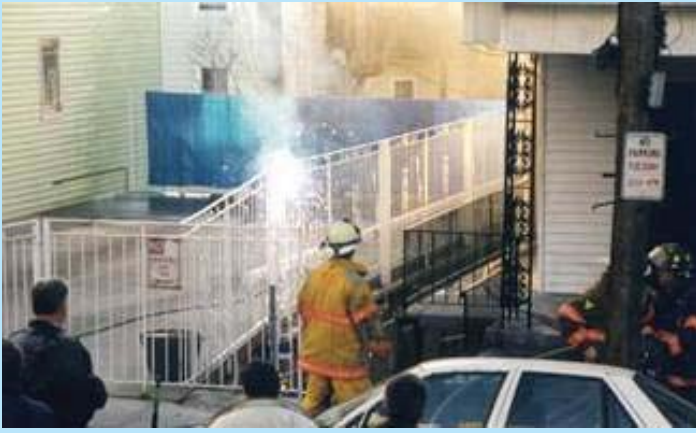
สายไฟที่ต่อเข้าบ้านขาดลงมาพาดกับรั้วเหล็กทำให้เกิดการช็อต จะต้องไม่เข้าไปใกล้ในระยะประชิดอย่างเด็ดขาดจนกว่าจะแน่ใจว่าได้มีการตัดไฟแล้ว
