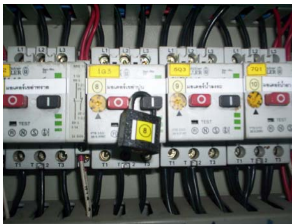
อุปกรณ์ตัดจ่ายแหล่งพลังงานที่มีจุดที่สามารถล็อกได้
